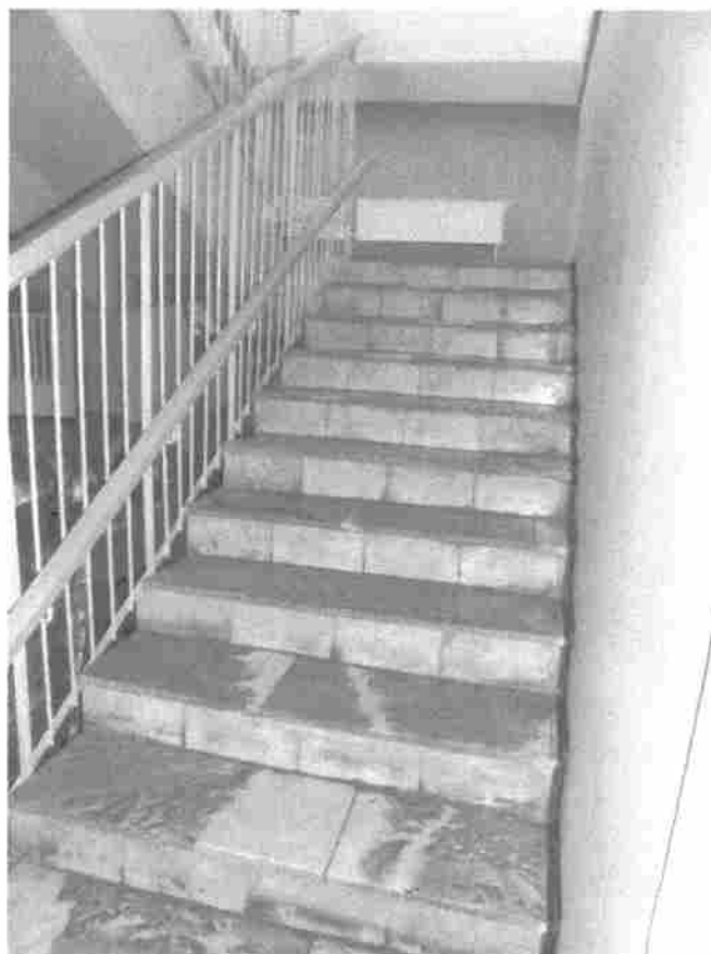
Фото 26. Лестница внутри здания
