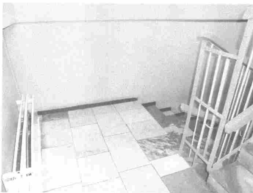
Фото 24. Лестница внутри здания
