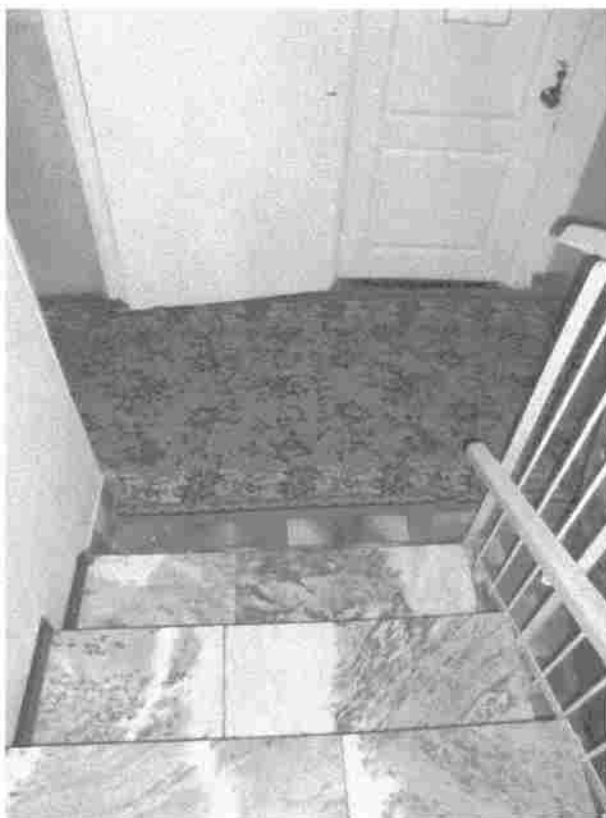
Фото 25. Лестница внутри здания
