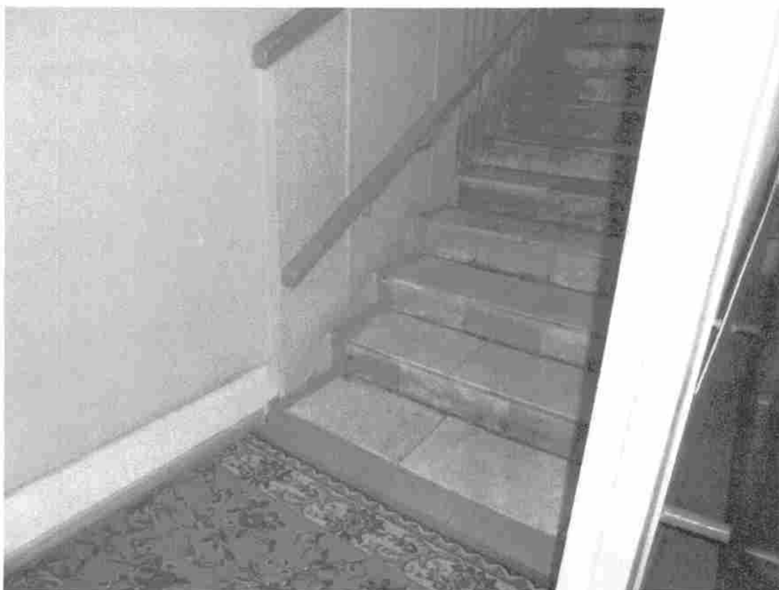
Фото 27. Лестница внутри здания
