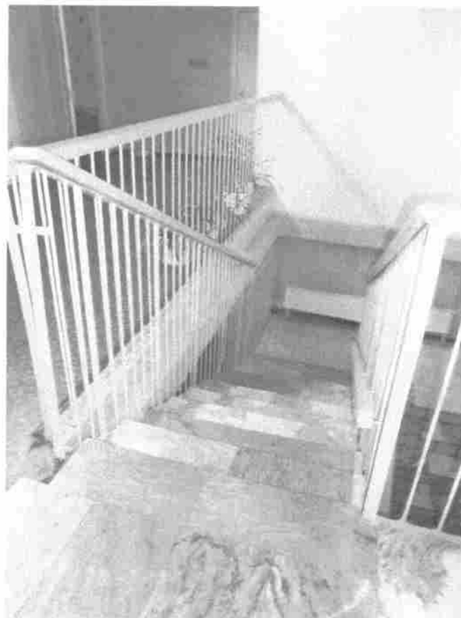
Фото 23. Лестница внутри здания
